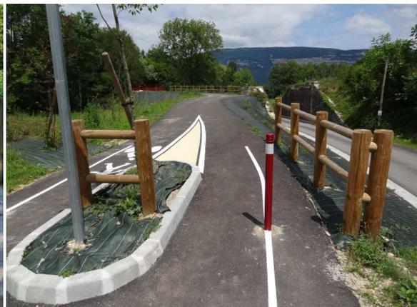
*Montalieu-Vercieu (38) : le potelet métallique inamovible ne permet pas le passage d'un vélo avec remorque et l'entrée de véhicule de secours : retirer le poteau central.*
