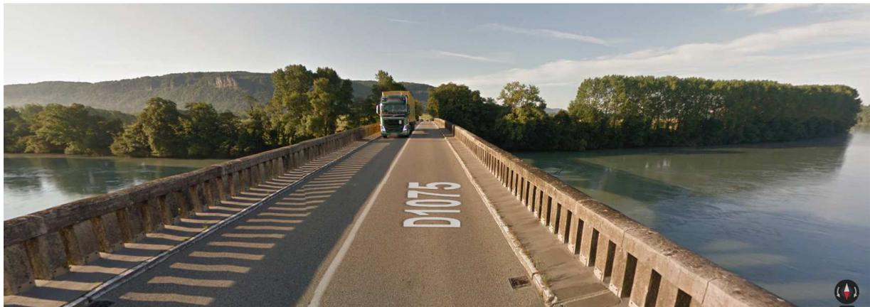
*Franchissement du Pont de Lagnieu : une passerelle côté aval sera nécessaire à terme, dans l'immédiat, diminuer les vitesses et envisager la réalisation d'une chaussée à voie centrale banalisée (CVCB) comme à la Roche de Glun dans la Drôme.*
