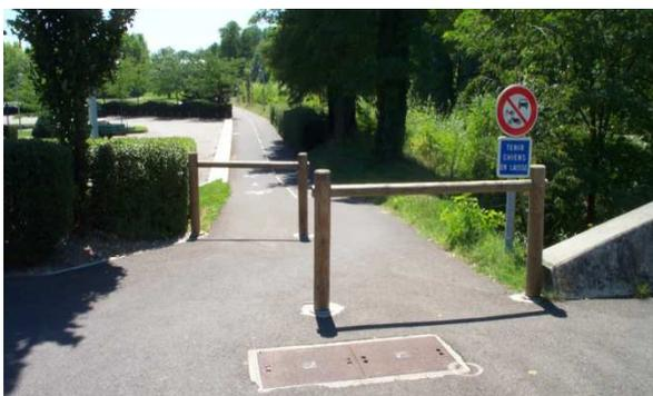
*Barrières en chicane espacées (73) : l'espacement permet de faire passer tous les usagers mais pose des problèmes d'écoulement de flux. Une demi-barrière a finalement été retirée*
