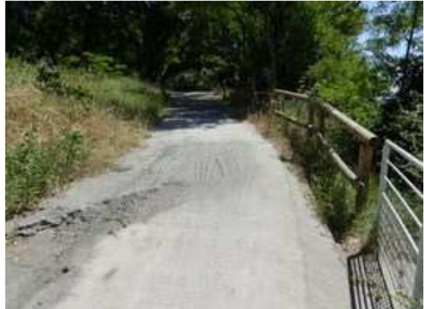
*Cas plus gênant de déversement de gravier sur la voie verte et d'arrachement du revêtement, accès au pont de Viviers rive gauche (26)*
