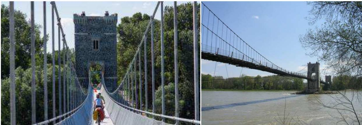
*Passerelle Himalayenne de Rochemaure est une magnifique réalisation en deux travées de 141 et 146m et de 1.4m de large. Elle devient un point d'intérêt en tant que telle (photo Ardèche Guide)*
