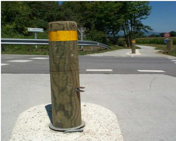
*Plot en bois muni d'un réflecteur et d'un revêtement rugueux d'avertissement (73). L'un a été retiré, l'autre remplacé par un plot plastique à mémoire de forme*
