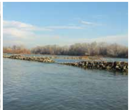
Photo 1 - Casier Saxy. L'ouvrage de grande taille, construit vers 1905 en amont d'Arles, n'est colmaté que partiellement, en raison de la réduction des apports au xx e siècle. Orthophoto 2003 ® © IGN - PFAR 2000 CRIGE et photo G. Raccasi, Aix-Marseille Université
