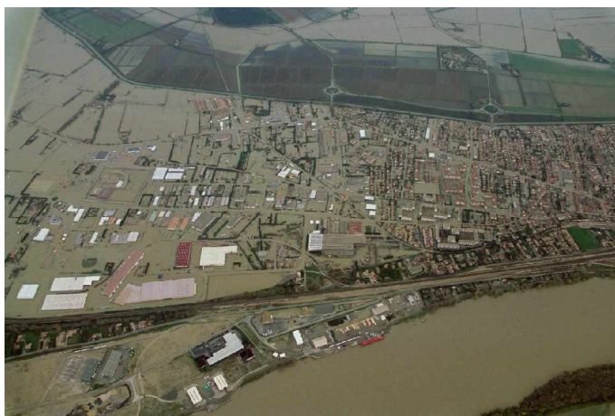
Le Trébon et Monplaisir inondés à Arles Source : Mairie de Tarascon
