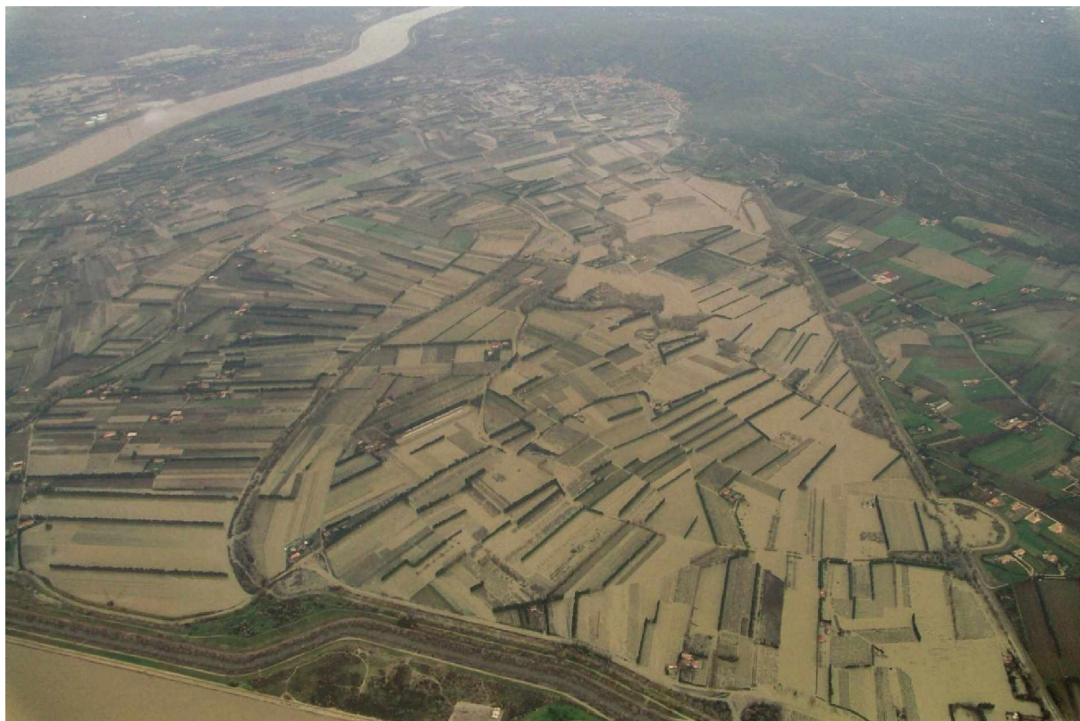
Plaine de Boulbon-Vallabrègues, vue depuis le sud-ouest. Digue de la Montagnette. Source : Mairie de Tarascon
