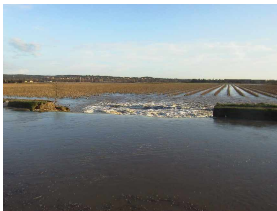
Brèche à Fort d'Herval le 4 décembre 2003 Source : CETE Méditerranée - CEMAGREF Aix-en-Provence
