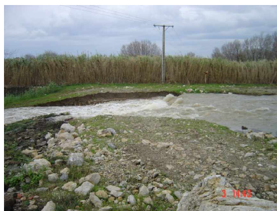
Déversoir CNR le 3 décembre. Source : Cemagref
