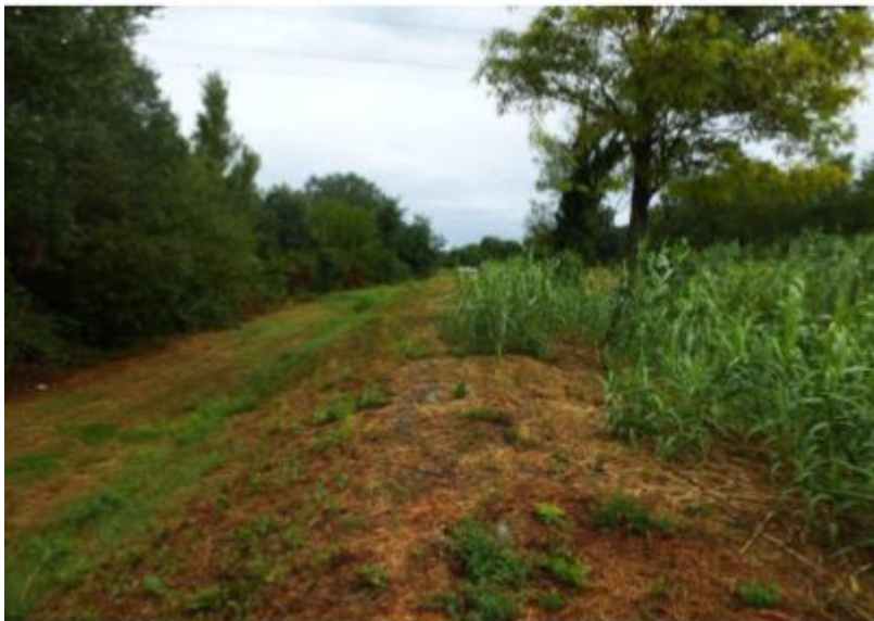
Fig. 1. Digue existante (nov 2016)
