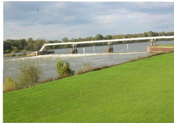
Clapets en phase de montée des eaux
