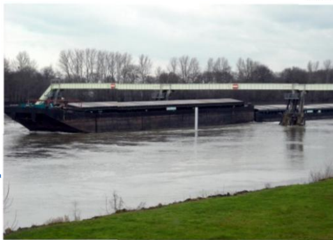
Clapets en phase de crue
