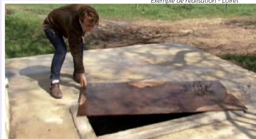
Exemple de réalisation - Loiret
