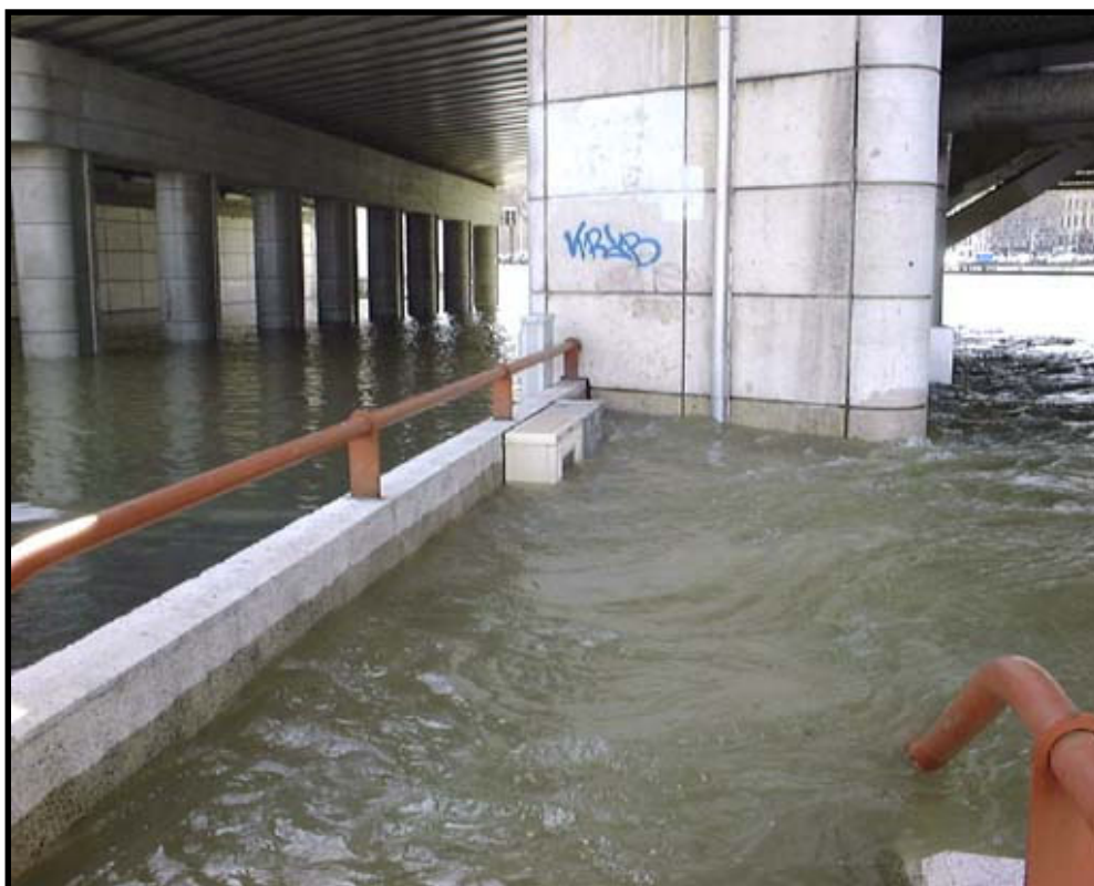
Photo 15 : Immersion d'une borne basse Quai Gillet à Lyon (source Division Éclairage Public Lyon)
