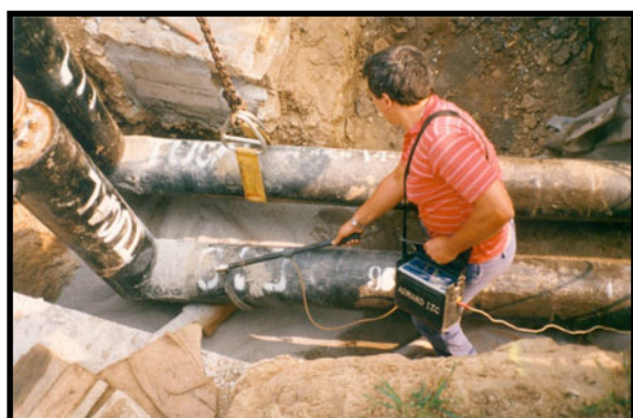
Photo 12 : Mise en œuvre de la technique Tucal (source Compagnie Générale des Eaux)
